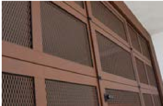
Scenario - profili alluminio SIMIL RAL a campione con rete di tamponamento
